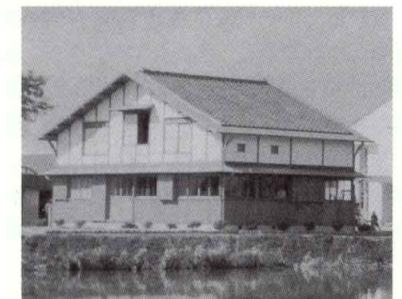
完成した牧師館 (1951-54年西条栄光教会アルバム No.1)
