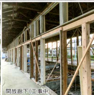
渡り廊下(解体中)
